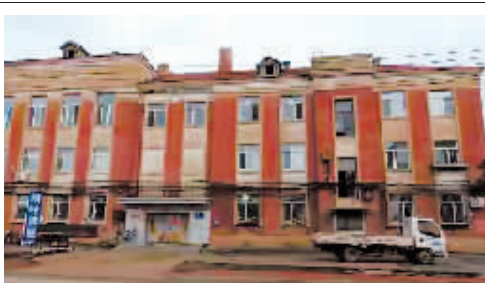
位于平房区东轻小区的苏式建筑风格住宅。
