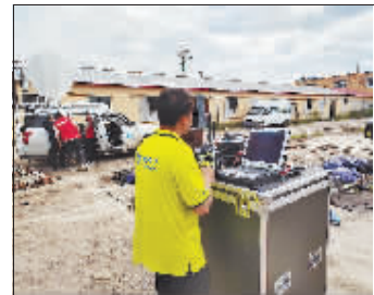
抢修通信设施。
