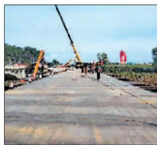
五常市交警部门组织70多名施工人员、40余台(套)大型机械,在和平大桥旁搭建临时便桥。这座临时便桥的长度与和平大桥相当,宽9米,两侧留有人行通道,承载力达到100吨。目前,打桩等工作已经完成,正在进行桥面施工,临时便桥预计9月1日前竣工通车。
