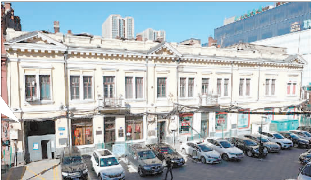
位于道里西十四道街的乐天照相馆旧址。
