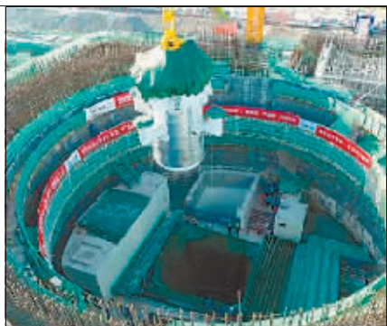
建设中的“玲龙一号”。
