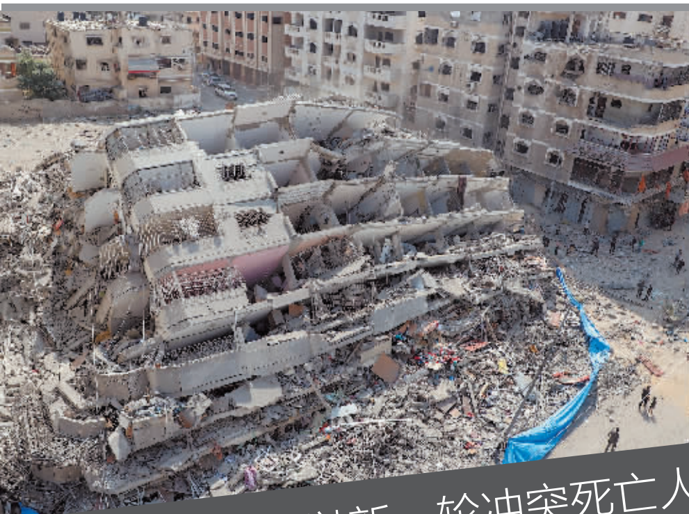
以色列空袭加沙城后的建筑废墟。
