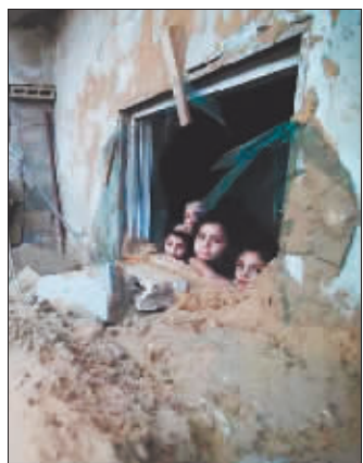
在加沙地带南部城市拉法，儿童在遭以色列空袭后的受损建筑中向外张望。
