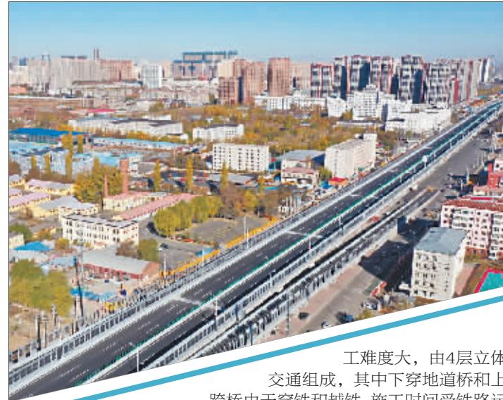
工难度大，由4层立体交通组成，其中下穿地道桥和上跨桥由于穿铁和越铁，施工时间受铁路运行制约，工程指挥部会同施工部门采取上跨桥和下穿地道桥同步作业的方式，优化顶进与顶推方案，抢先抓早克服重重困难，顺利完成顶进工作。
