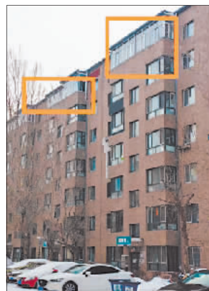
A18栋顶层的私建阳台。
