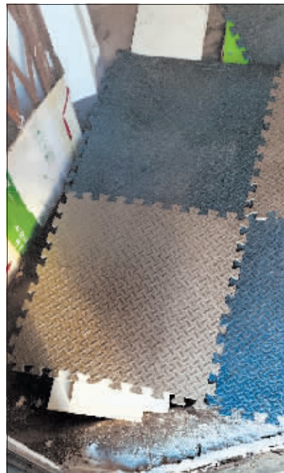
木板上铺盖上废弃的胶垫。
