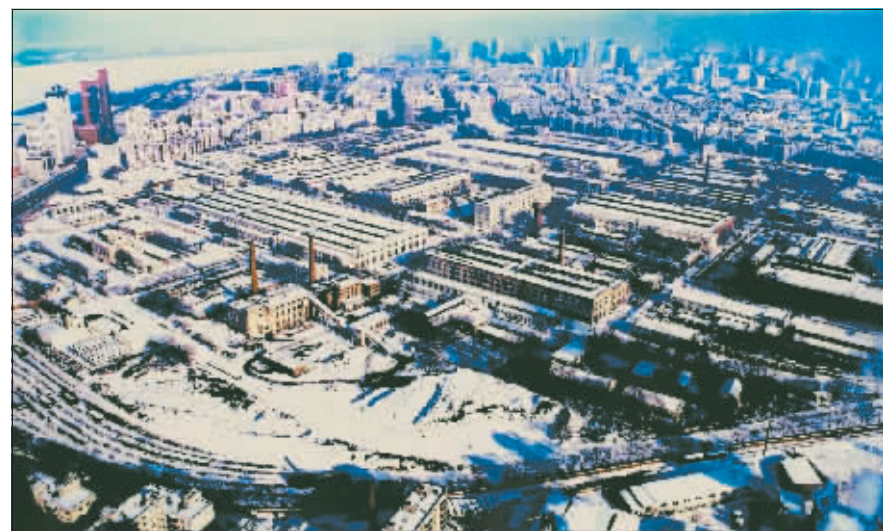
宋文勇航拍的车辆厂厂区。
