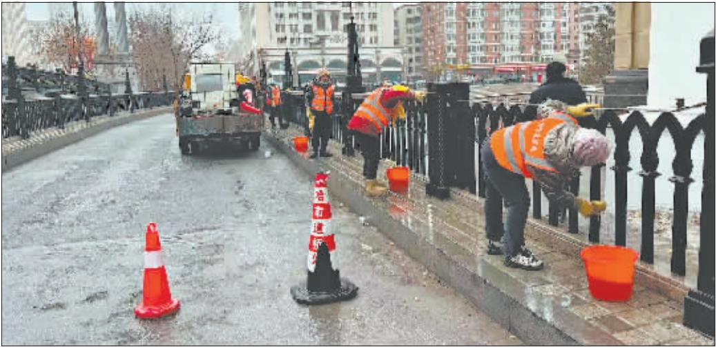
本报讯(崔彦 实习生 黄宸祺 记者 黄曼君 文/摄)随着气温逐步升高,冻胀融沉等导致的春季道路翻浆破损的问题陆续显现,哈市道桥中心组织市、区各城市道路管护部门全面启动春季集中整修工作。截至目前,全市共维修城市道路616条段,面积2.35万平方米。
