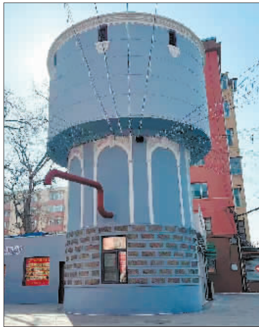
香坊“水楼子”里还保留着原有管线。
