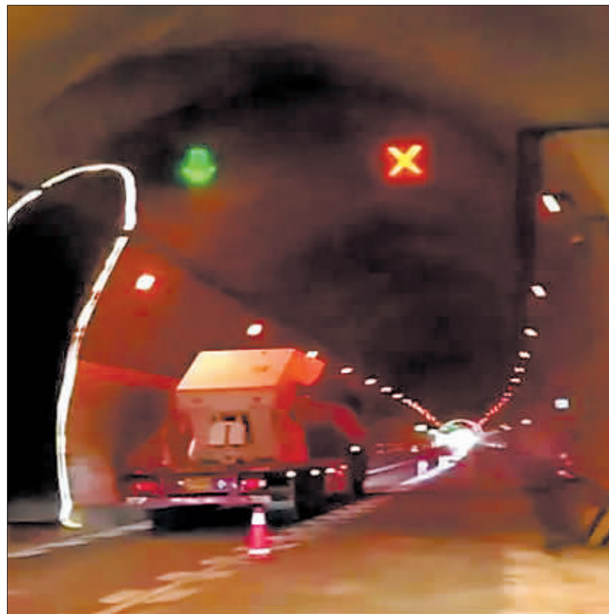
大巴发生事故的西家塔隧道内部。
