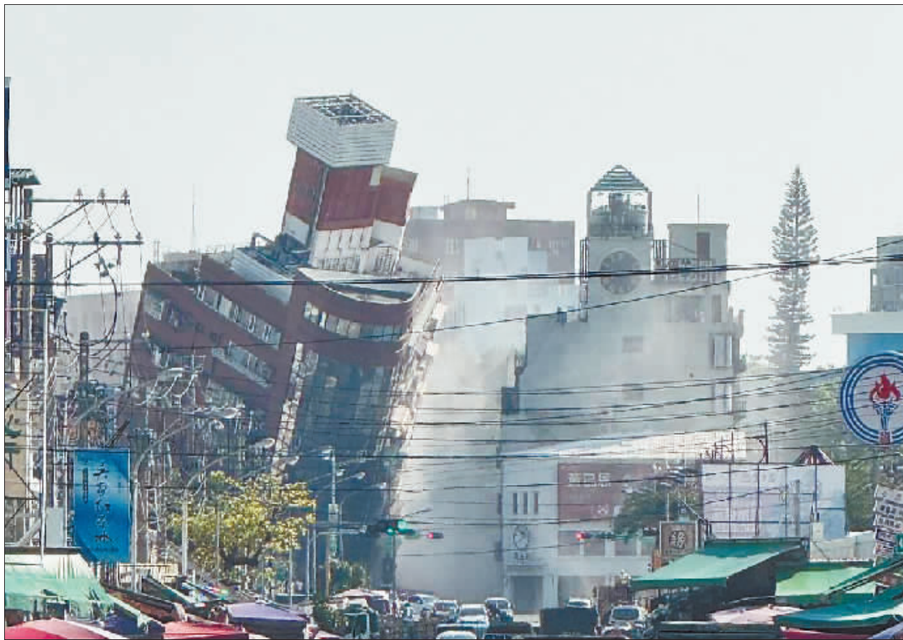
强震发生后，花莲县一栋大楼大幅度倾斜。
