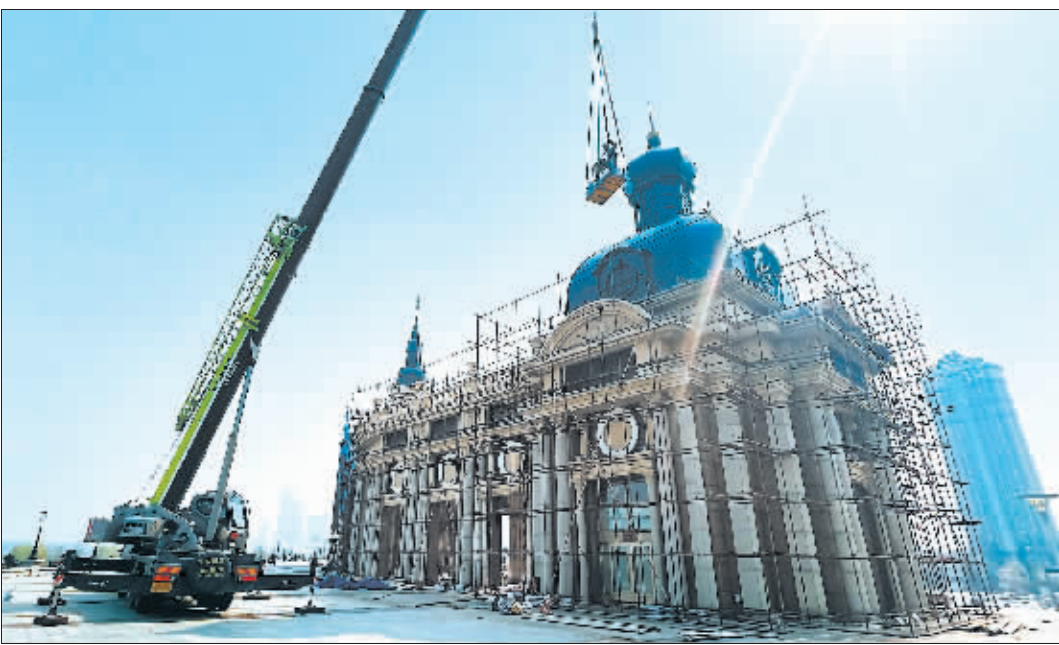
22日,道里区音乐公园内,施工人员开始对音乐长廊的立面、穹顶等进行全面整修漆饰。待施工完毕后,音乐长廊这个冰城旅游打卡地将以崭新的面貌迎接各地游客。 本报记者 刘达齐 摄
