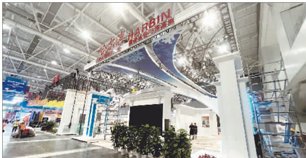
哈尔滨馆正在紧张搭建中。
