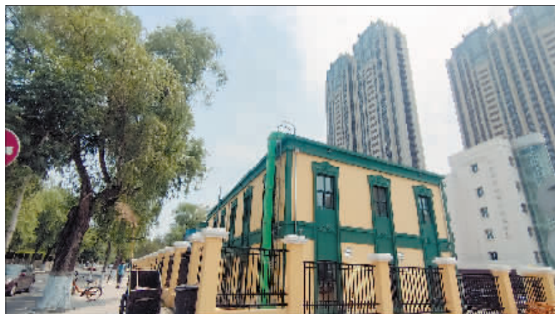
十六道街系统完善工程。
