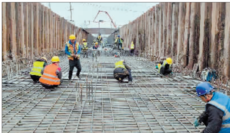
马家沟截流方渠项目。
