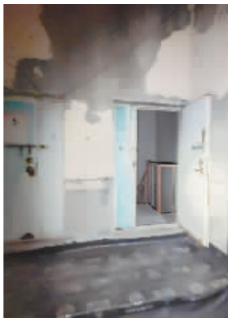
居民要从消防通道下楼回家
