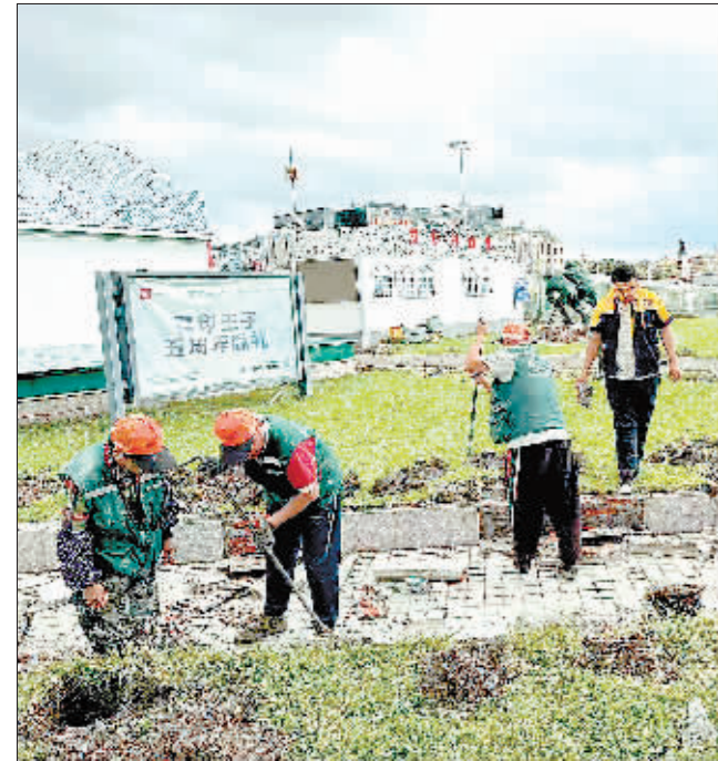
颐园广场改造施工现场。
