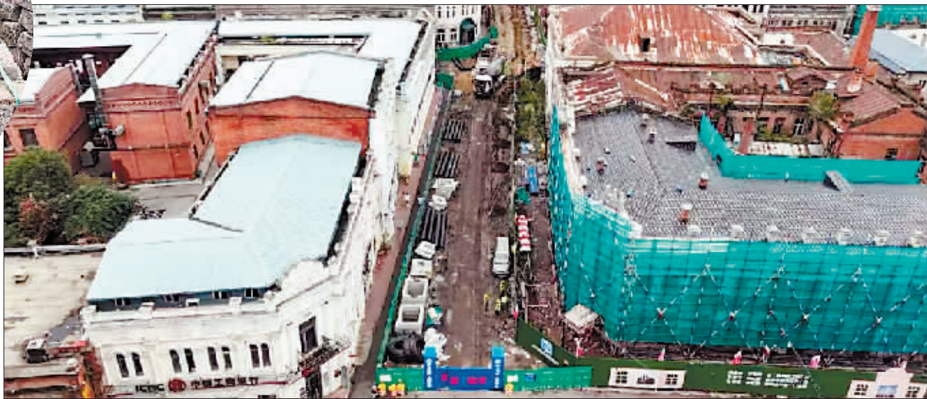
靖宇街改造进行中。 本版图片均为资料片
