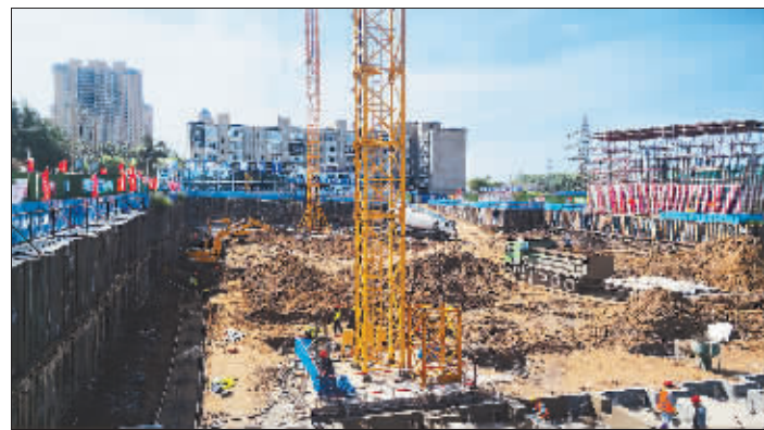
配售型保障房施工现场。
