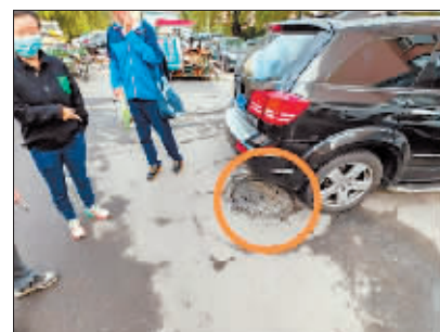
社区清理了部分排水井。
