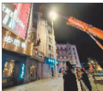
建立了清晰明确的点位台账,同时第一时间联系拆除队伍现场勘查。
