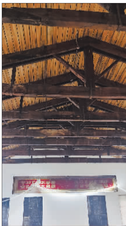
议事厅正在修复。
