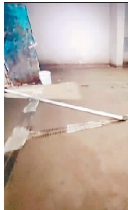
用管线将渗水导入地沟。
