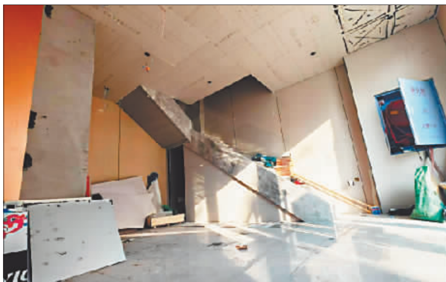
尚未完工的诊所大厅。
