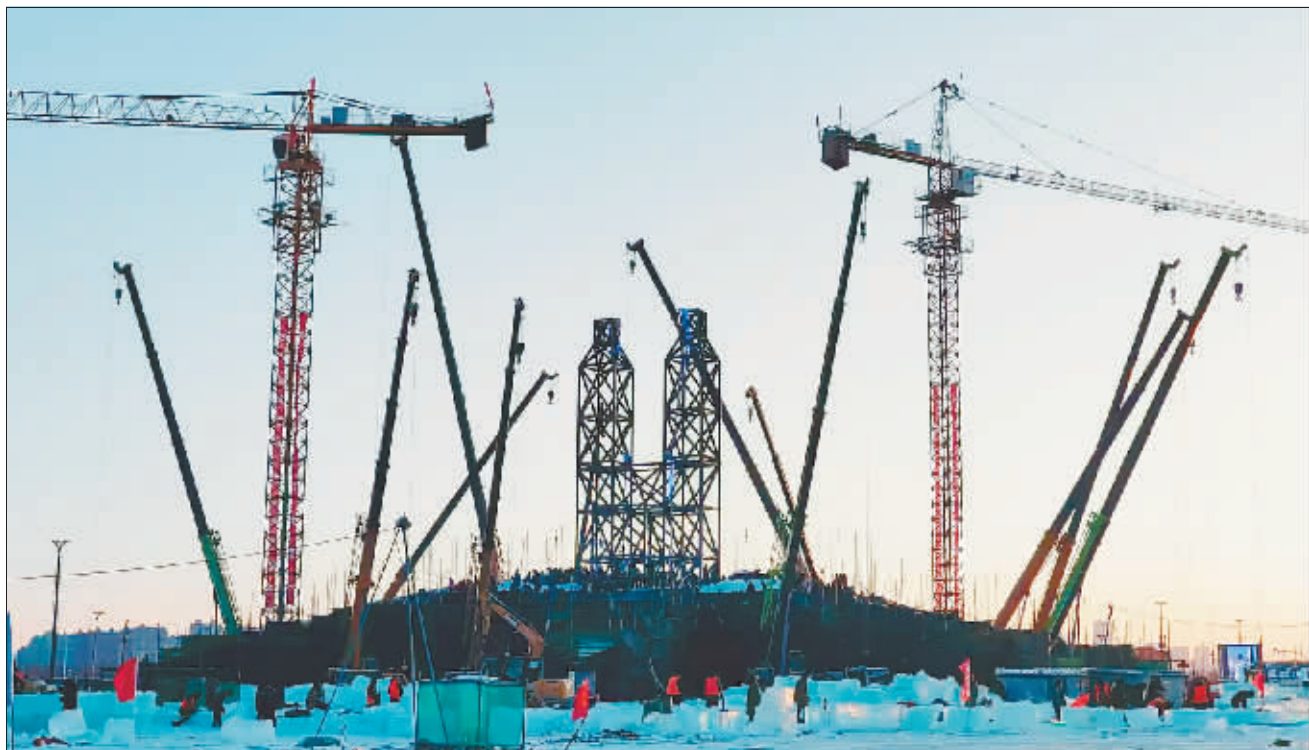
哈尔滨冰雪大世界施工现场。
