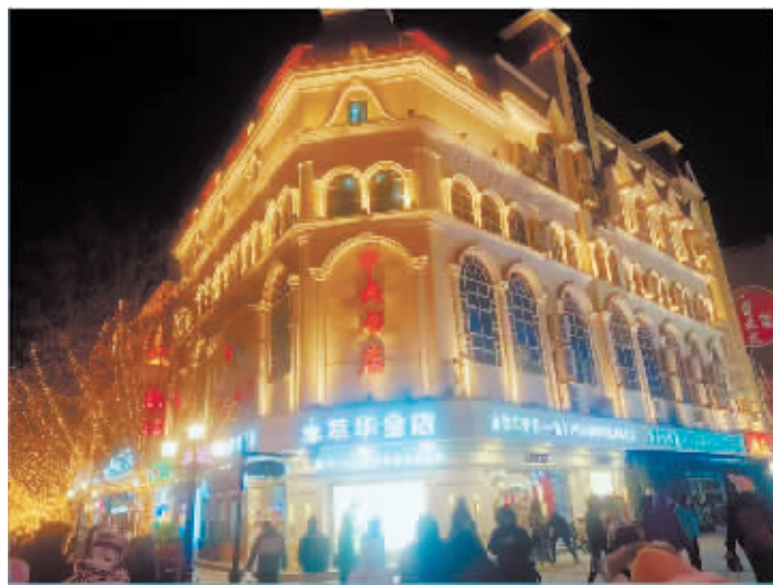
中央书店楼体照明施工后。
