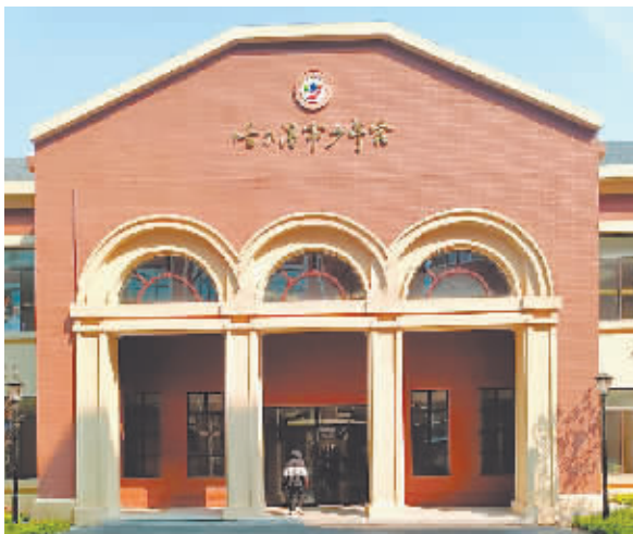
位于南岗和兴路的省艺校校舍旧址。
